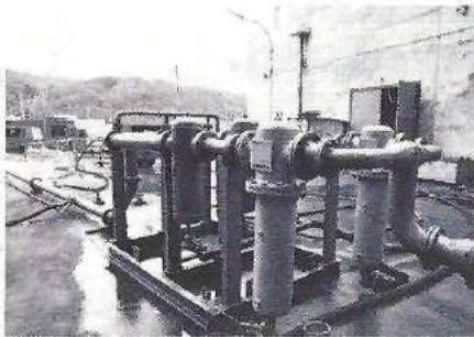
Bild 13 Aufbereitung von Prüfluft für die Dichtigkeitsprüfung in einem Kraftwerk
